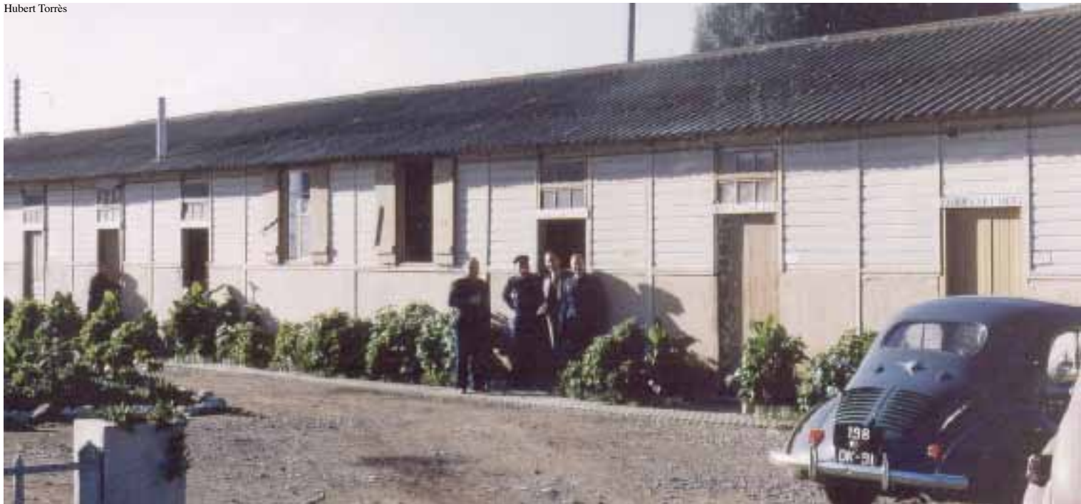
▲ Les installations de l'ERALA 1/40 à Maison-Blanche
